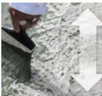
Aplicar una primera mano de **weber.tec membrana** con brocha sobre el sustrato limpio cargando en un espesor aprox. de 1 mm. Dejar secar.
