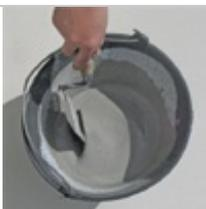
Mezclar en un balde, volúmenes iguales de **weber.tec membrana** parte líquida y parte sólida, teniendo la precaución de agregar el líquido paulatinamente para evitar formación de grumos.
